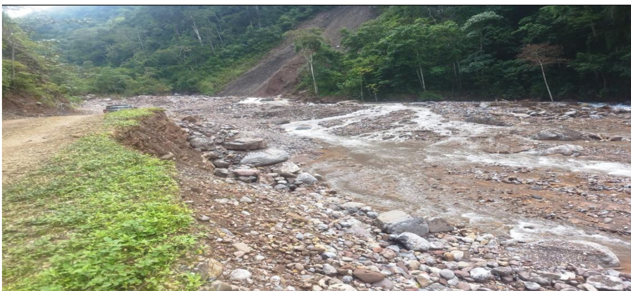
FIGURA N° 04: SE APRECIA COLMATACIÓN DE CAUCE CON MATERIAL DE ARRASTRE EN EL RÍO CHANCARIZO
