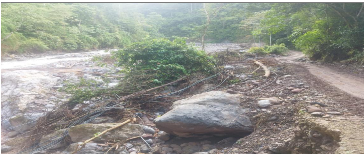
FIGURA N°02: EN LA TEMPORADA DE MAXIMAS AVENIDAS, EL RÍO CHANCARIZO SE DESBORDA, AFECTANDO LA CAPA DE RODADURA DE LA TROCHA CARROZABLE.
